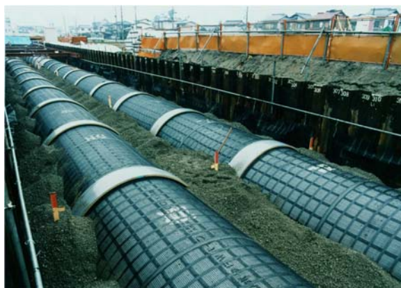
図2 ジオグリッドを用いた大口径パイプライン 浅埋設（農村工学研究所）
